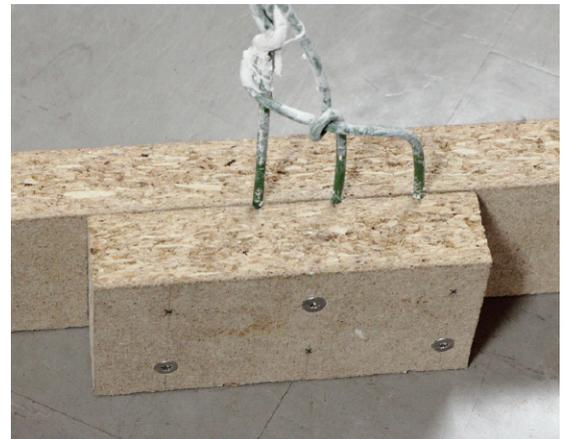
Fixierung Fahnenstab mittels Schrauben
