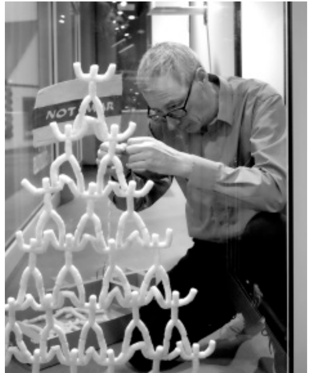
Aufbau der Installation (2) *
